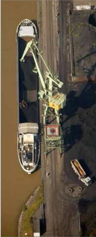
Noch sind Wendemanöver nur kleinen Schiffen möglich. In zwei Jahren soll das Wendebecken auf der anderen Seite fertig sein.
