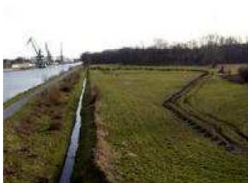
Die Bohrstellen in der Wiese neben dem Kanal zeigen die Ausmaße der Erweiterung. Foto. Goldstein
