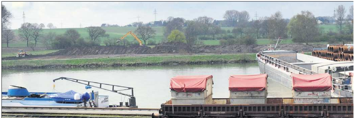
Das Wendebecken entsteht auf der dem Stadthafen gegenüberliegenden Seite. Zur Zeit laufen die Oberbodenarbeiten.
